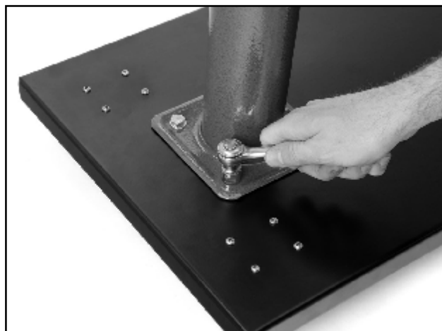
Figure 3. Installation du support de collecteur.
